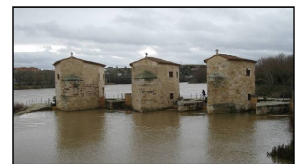
Los molinos de la Parada del Puente de Córdoba conservan una planta con la característica forma de aceña del Guadalquivir, rematada en ábside semicircular por su parte superior (Plano: J. Cuenca). En cambio, las del Duero suelen presentar en su cabecera forma de tajamar para encauzar las aguas (Aceñas de Olivares, Zamora. Foto: J. M. Garrido)
