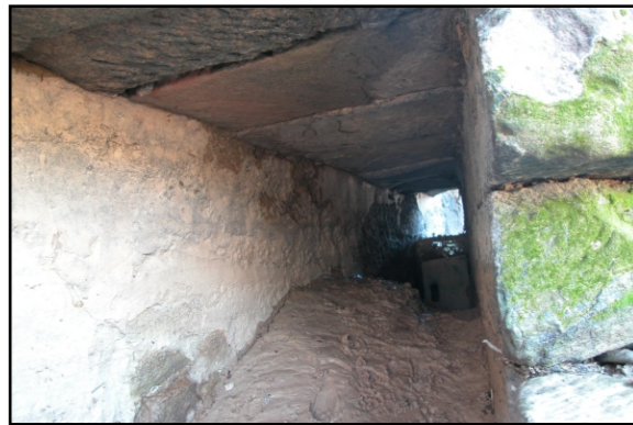
Sección interior de los canales en los molinos de la Huerta Mayor y Los Torrejones
