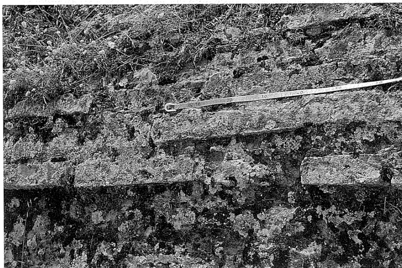
5-6. Detalle del aparejo constructivo de una de las cúpulas del aljibe de Bujalance y de la bóveda del aljibe de Carcabuey. Además de en el sentido de colocación del ladrillo (radial en Bujalance y longitudinal en Carcabuey), se observa una clara diferencia en su tamaño y grosor y en las dimensiones de la lechada de argamasa que los traba
