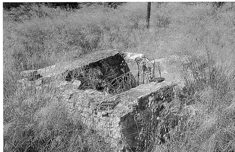
8. Pileta para la recogida de agua en el castillo de Bujalance. Ubicada a escasos centímetros del aljibe, está conectada mediante un canalillo cubierto a la parte superior de una de sus cúpulas, por donde vertería el agua al interior de la cisterna
