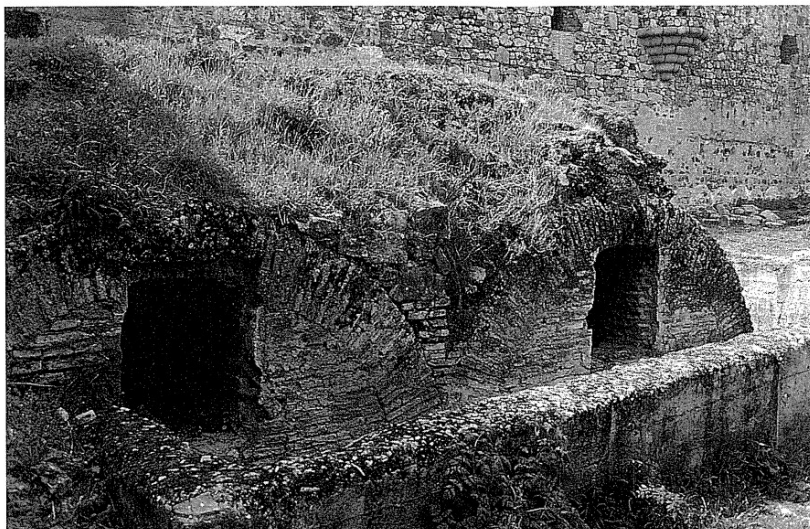
3. Vista exterior del aljibe del castillo de Medellín (Cáceres). En él se aprecian con claridad las dos bóvedas de medio cañón paralelas de ladrillo que, separadas por un doble arco, configuran el espacio interior del depósito
