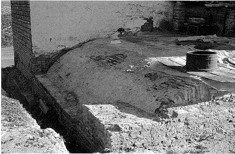
13. Aspecto exterior actual de las bóvedas de medio cañón de ladrillo que cubren el aljibe de la torre Abolafia
