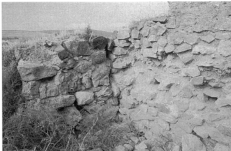
19. Lienzos interiores del aljibe de Benajemí, edificados con pequeños mampuestos sin argamasa que en la actualidad aparecen completamente descarnados
