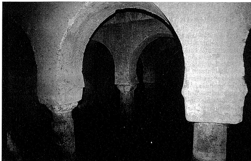
1. Vista interior del aljibe de la Casa de las Veletas de Cáceres. Este depósito del siglo X es, con sus doce espacios internos, uno de los mayores de la Península. Conservado en el subsuelo del actual Museo Arqueológico, estuvo destinado al abastecimiento de la población y siguió en uso durante época bajomedieval
