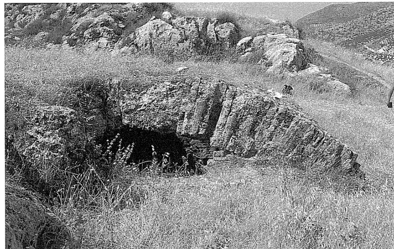
19. Lienzos interiores del aljibe de Benajemí, edificados con pequeños mampuestos sin argamasa que en la actualidad aparecen completamente descarnados
