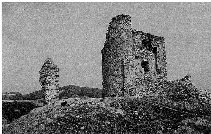
18. Vista general del castillo de Gome Arias, desde el interior de su plaza de armas. El aljibe se ubica junto al lienzo más pequeño de muro, al NE de la torre del Homenaje
