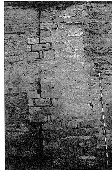
FOTO 5. Machón de sillería en la cara interna de la muralla, ubicado entre las torres 1 y 3
