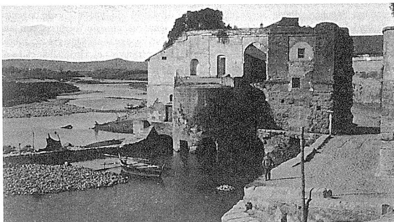
Figura 2: Fotografía tomada a principios de siglo donde se puede apreciar el tramo de acueducto que entonces se conservaba de la noria medieval, compuesto por tres arcos en su lado Este, parcialmente cubiertos por las edificaciones del molino.
