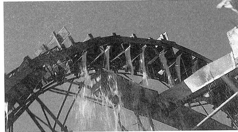
Figura 6: En esta vista de la noria de Jauja en funcionamiento se puede apreciar cómo se produce el vertido del agua de los cangilones, por el costado interno de la noria, sobre el añakil. A éste va unida la mangueta o artesilla que sirve de conexión con el acueducto que transporta el agua extraída.
