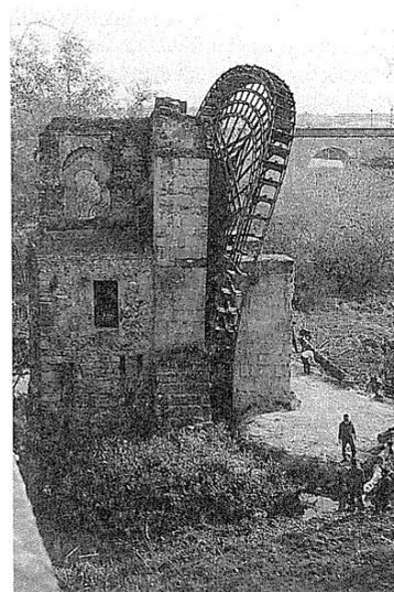
Figura 4: Fotografía del año 1992 donde se puede observar el estado actual del molino, tras la intervención de Félix Hernández en 1965, y el estado de extremo alabeo que presentaba la rueda antes de su reposición en 1994.
